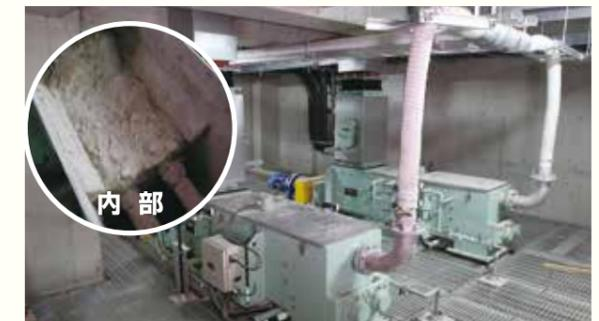
飛灰と重金属処理剤をよく混ぜ合わせて、飛灰中の重金属を安定させます。
