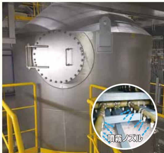
塩化水素、硫酸化合物は排ガス洗浄装置にて、苛性ソーダ（水酸化ナトリウム水溶液）を吹き込むことで除去します。
