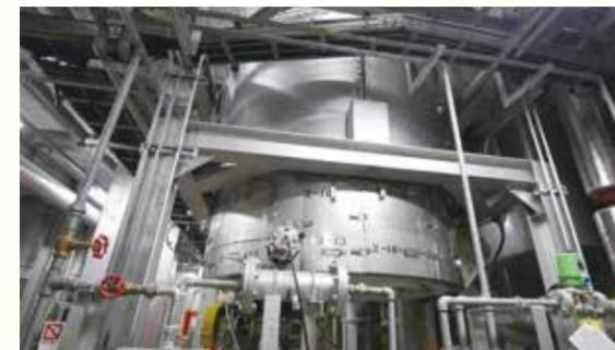
飛灰を400℃以上に加熱し、ダイオキシン類を揮発脱離させて除去する装置です。
