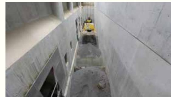
発生した焼却灰や飛灰は搬出するまで灰ピットに貯留します。また、灰運搬車への積み込みは、自動で行われます。
