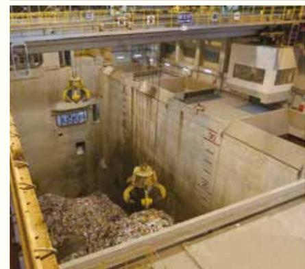
ごみピットに貯めたごみは、クレーンにて十分に攪拌したのち、焼却炉のホッパに投入します。
