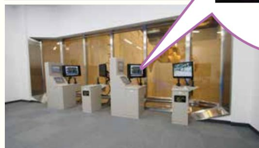
ごみクレーン操作室にある操作画面を見ながら遠隔で運転します。通常は自動で運転しています。
