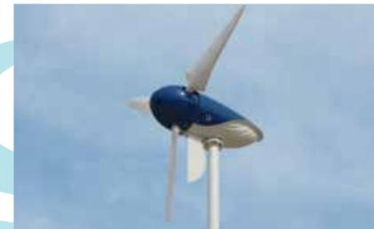
鯨をモチーフとした1kWの風力発電設備を2台設置しています。風という再生可能エネルギーを利用して発電し、工場棟に電力を送っています。
