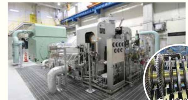
ボイラで発生した蒸気の多くは、タービンに供給して発電を行っています。得られた電気は、工場内の設備や照明などに利用し、余った分は電力会社へ売却しています。
